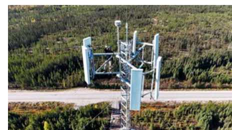
Installation des équipements sur la Route Billy Diamond (photo courtoisie YRH)
