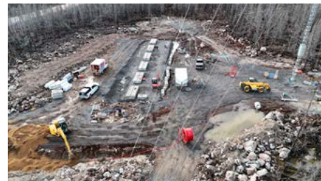
Construction d'un site sur la Route de Waskaganish (photo courtoisie YRH)
